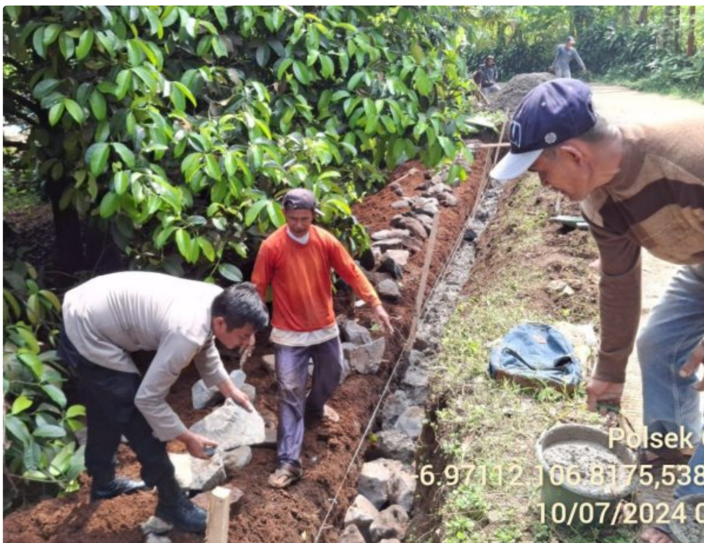
Monitoring Dana Desa untuk Pembangunan TPT Jalan Desa di Bojongkembar Polsek Cikembar Polres Sukabumi
