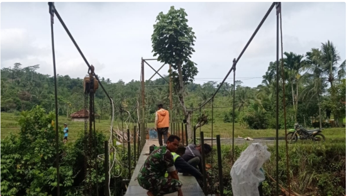
Kpt Arm Witono: Pengerjaan Jembatan Gantung Sudah 80%
