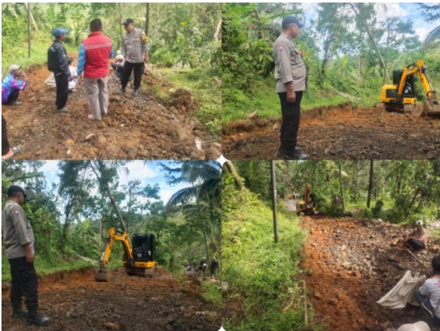
Bhabinkamtibmas Polsek Kalibunder di Desa Balekambang Pantau Perbaikan Jalan di Kampung Babakan
